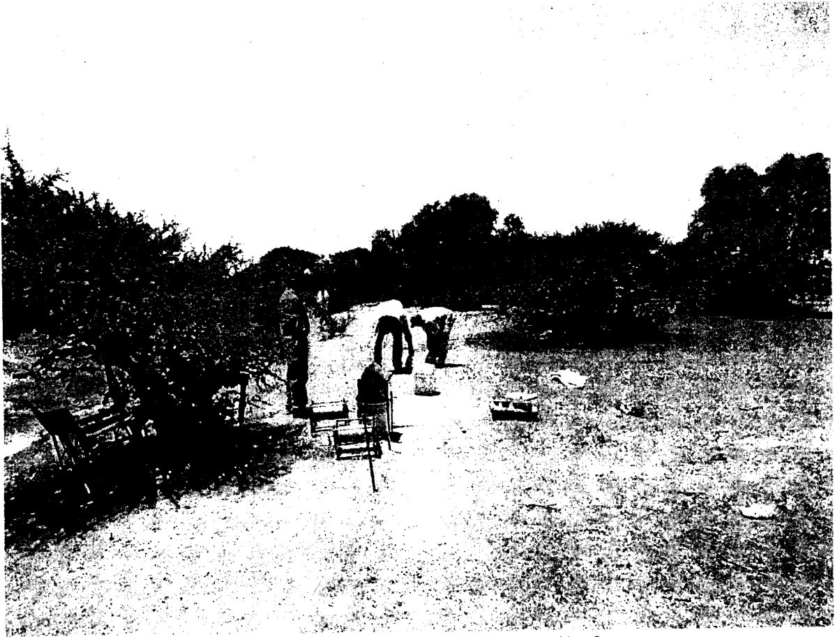
EJECUCION DE LOS TRABAJOS DEL SEV No. 2
